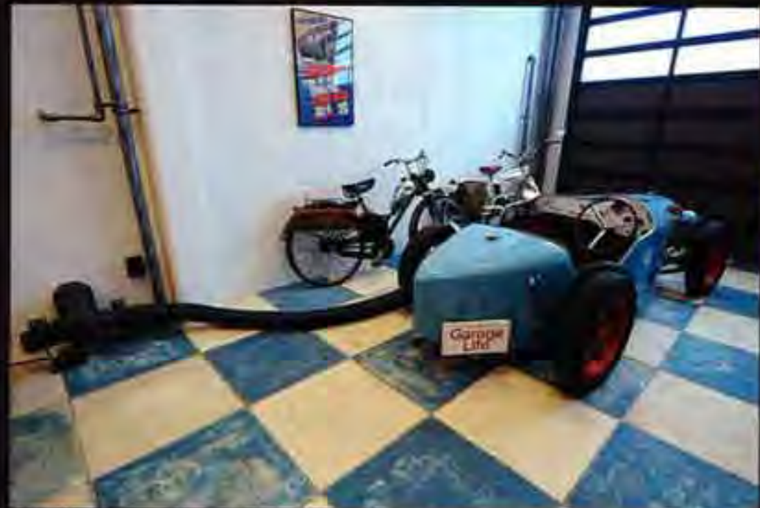
窓が外に濡れないように、開口は少なく小さく設置。そのため換気扇も設置していないので、排気ガス対策として排気ダクトシステムを導入した。
