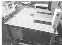
屋根の緑化を目指して思案中。しかし、そのための折板屋根になっていないため土が流れること、雨水を流すことを考慮しないと失敗することになる。
