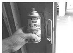
さすがにサイドドアの鍵がさびてきたため、緊急処置としてKURE-56で清らかに調整。本来であればメーカーに相談して鍵の交換なども検討中。
