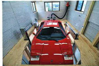
ガレージが寝室とドア1枚で隣接するため、寝室に排気ガスが侵入しないように選んだのは「セーフティライフ」が発売するEG WAY OUT。強制的にモーターで排気ガスを強制排出する装置。モーターは標準色はマッドブラックだが、ボディ同色でペイントやロゴも入れられるなどオプションサービスもあり。排気方向をカスタマイズすることもオーダーすることができる。写真は1989年ランボルギーニ・カウンタック・アニバーサリーに導入したEG WAY OUT。大排気量エンジンから排出される排気ガスも強制的に出すシステムを取り入れた。
